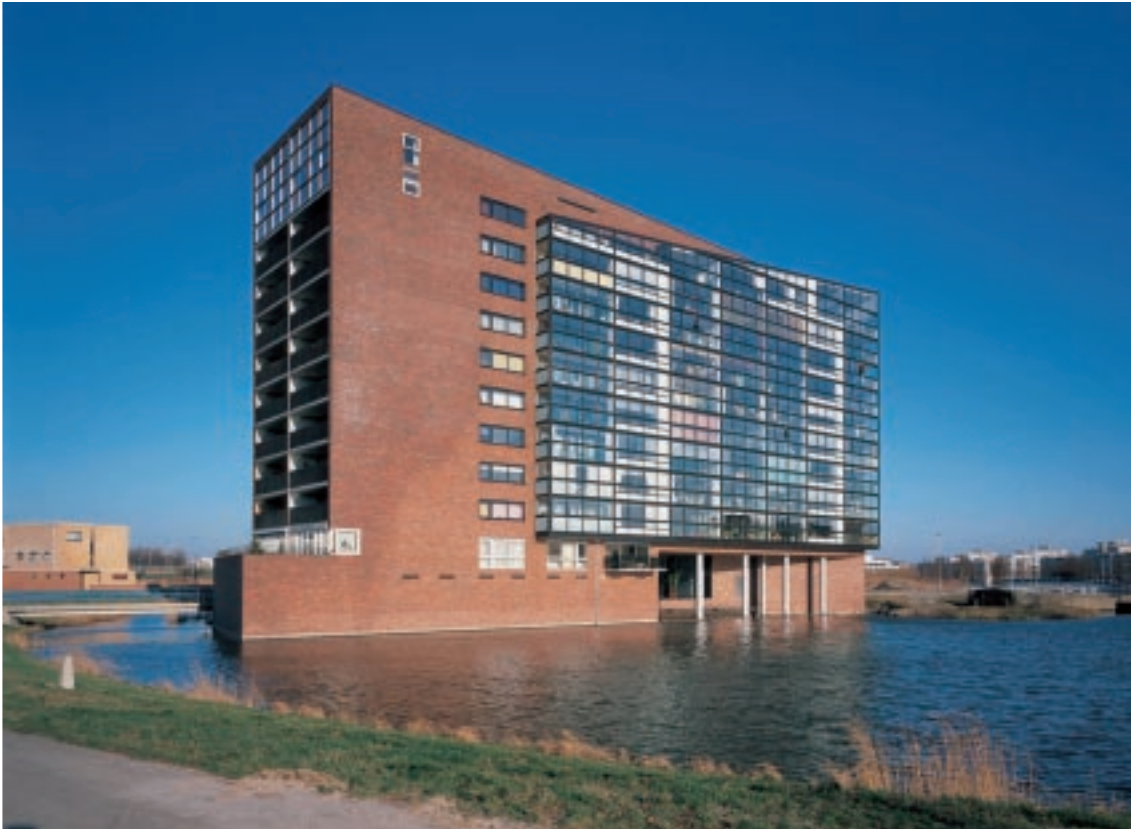
Zuidgevel met serres van het flatgebouw Cumulus dat met zijn voeten in een uitloper van de Albert Schweitzersingel staat.
