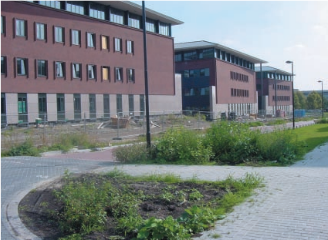
Met deze klassiek ogende gebouwen wordt de kantorenstrook langs de Mahatma Gandhisingel voltooid.
