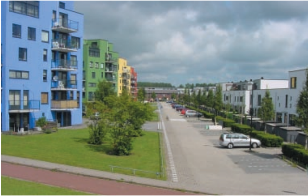
Blik vanaf de dijk naar het Fumahout. De achterzijden van kleurige urban villa's en de voorzijden van witte eengezinshuizen liggen tegenover elkaar.
