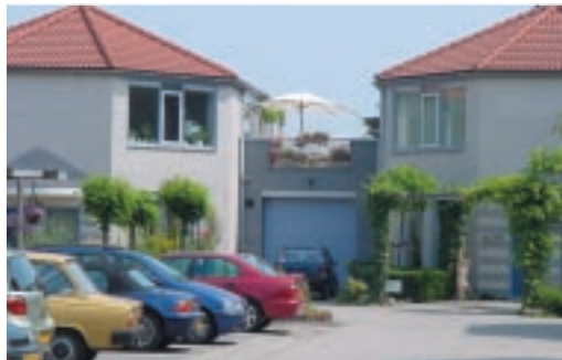
Postmodernisme (woon-werkwoningen aan de Blauwroodlaan).
