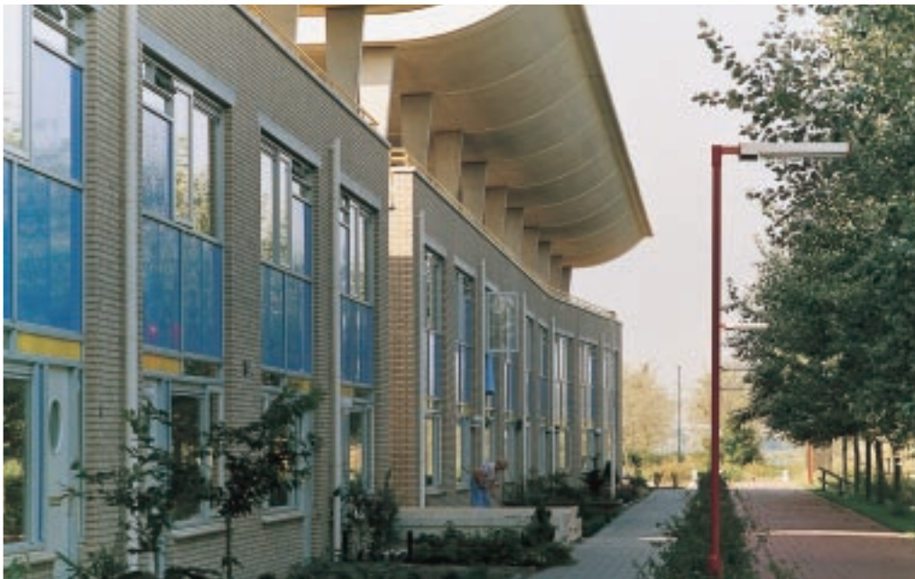
De laatste van de achtenvijftig vrije sectorwoningen met luifels langs de Florazoom met uitzicht op de Floraplas. Foto Pieter Weerda Architectenbureau
